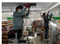
監視カメラ配線施工イメージです
