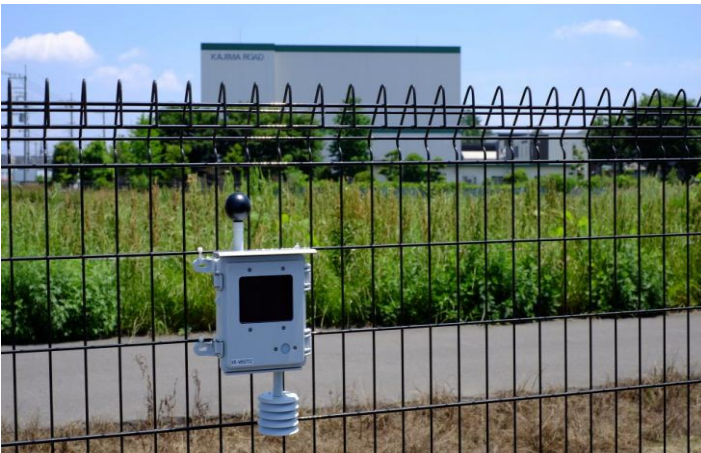
屋外設置型輻射熱測定器の様子
