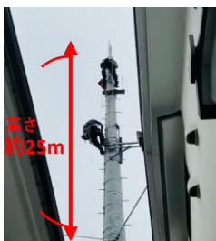
鋼管柱へ2名上っている様子
