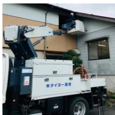
監視カメラ設置作業中
